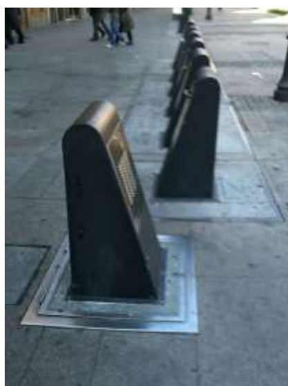
vista isola ecologica tipo interrata vista sistema a cassonetti interrati
