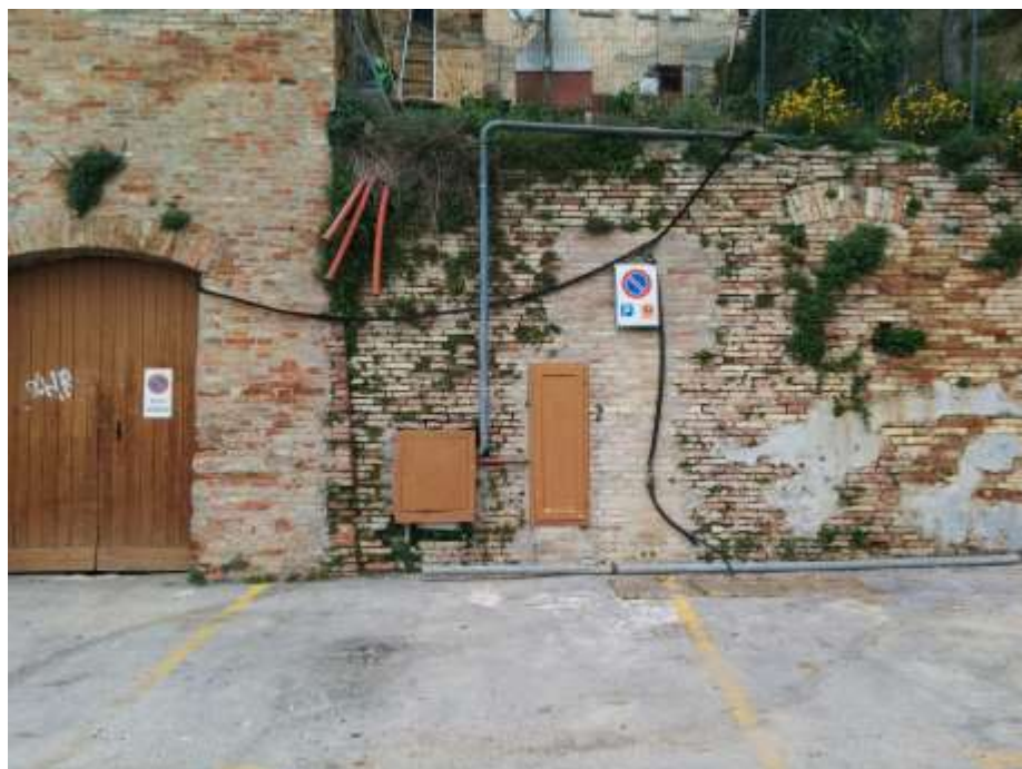
vista paramento murale di terrapieno allo stato attuale
