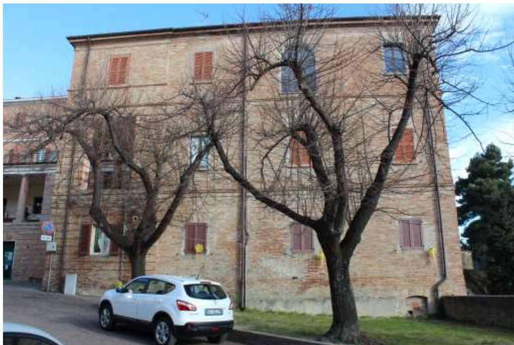
vista generale area
